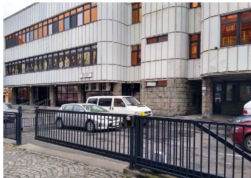
Wejście do budynku KMO i biura KTW GZM 2027 od ul. Sienkiewicza – bez schodów
